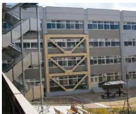
Фиг. 5. Новото антиземетръсно укрепване след плановия ремонт на две от университетските сгради в Ямагучи.
