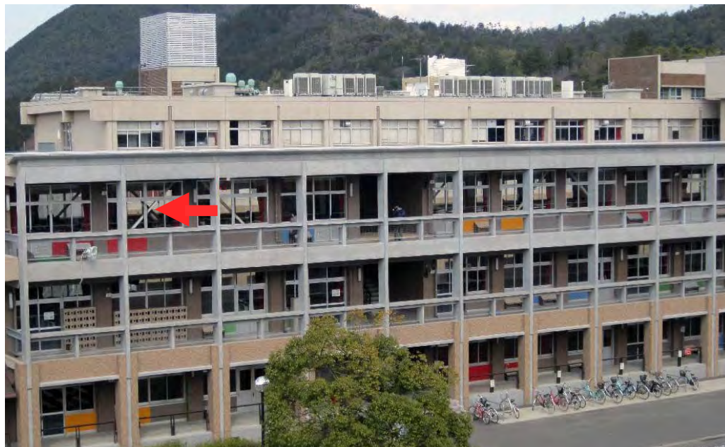
Фиг. 5. Новото антиземетръсно укрепване след плановия ремонт на две от университетските сгради в Ямагучи.
