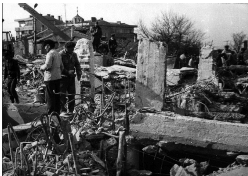
Фиг. 7. Разрушенията в Свищов след земетресението във Вранча, Румъния от 4 март 1977 г.
