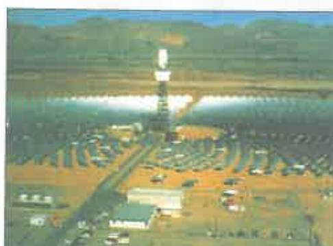
Фиг. 8.4. ▲ Енергийни източници на бъдещето: огледала, които фокусират слънчевите лъчи и захранват генератори за електрически ток в експериментално съоръжение в пустинята Мохаве, САЩ.
